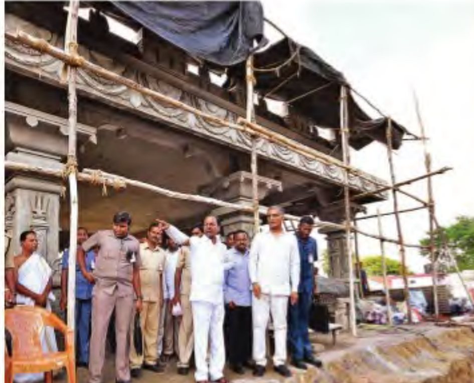
చింతమడక గ్రామంలో రామాలయం నిర్మాణ పనులను పరిశీలిస్తున్న సీఎం కేసీఆర్
