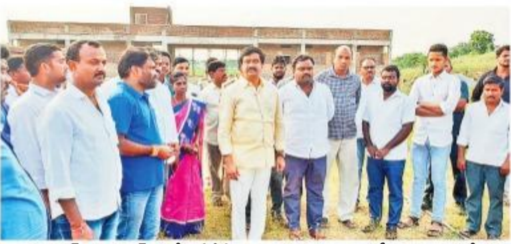
నిజామాబాద్ జిల్లా కమ్మర్లపల్లిలో మినిస్ట్రీడియం నిర్మాణ పనులను పరిశీలిస్తున్న మంత్రి వేముల
