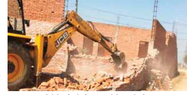
लोनी में अवैध निर्माण ढहाता जीडीए का बिल्डोजर
